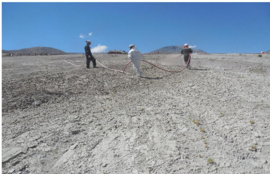
Ilustración 3 Registro fotográfico de Segunda Prueba de Aplicación de Supresor de Polvo
