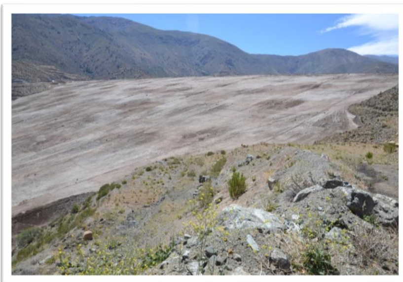
Ilustración 12 Registro fotográfico del muro después de la aplicación del Soltiac
